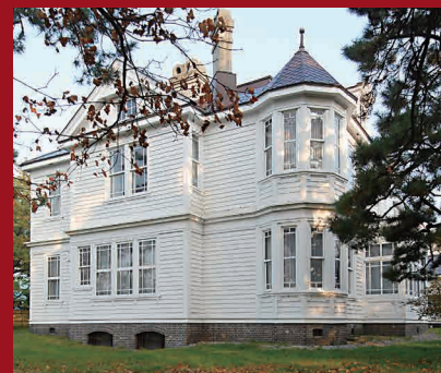
外観全景(現在改修工事中)
