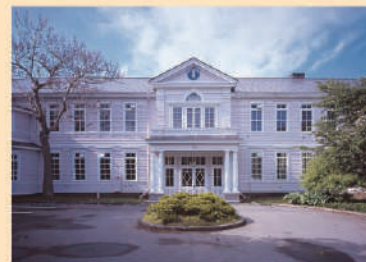
本館(2023年12月改修完了予定)
