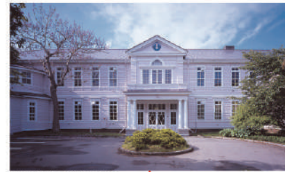
本館(現在修繕中です)
